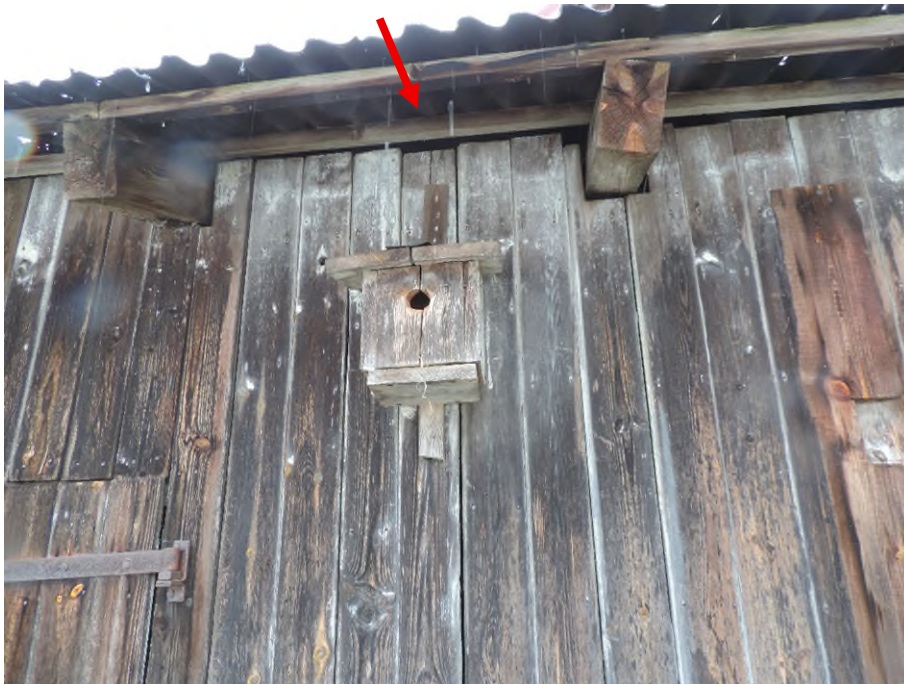
Bild 22: Höhlenbrüterkasten an östlicher Giebelseite des Nebengebäudes (Scheune); zusätzlich Einflugmöglichkeiten für Fledermäuse unterhalb der Dachkante (roter Pfeil)
